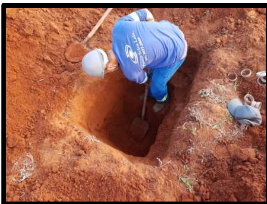
FOTO 2 - Abertura do furo com o auxílio de pá e picareta
